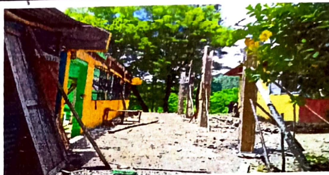
FOTO 2. Se empiezan a colocar paraes para fundir de cemento.
