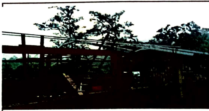
FOTO 6: Colocación de estructura metalica para techo.
