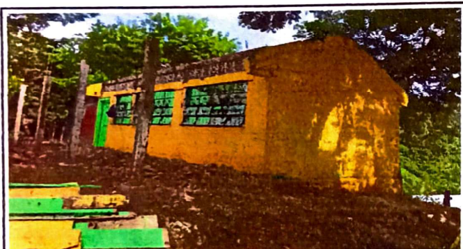
FOTO 3: Avance de como esta quedando la estructura del aula.
